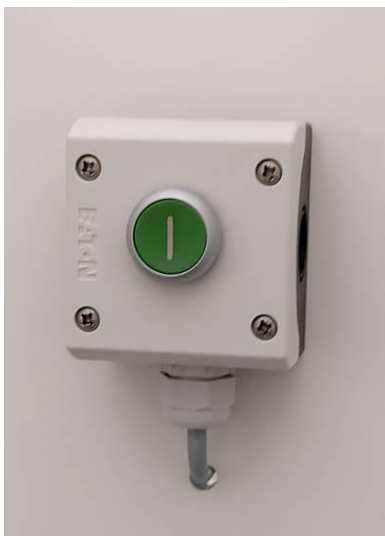
Caja de interruptores
