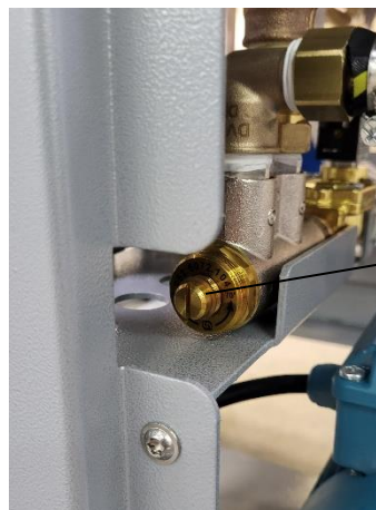
Mezclador sin tapa protectora
